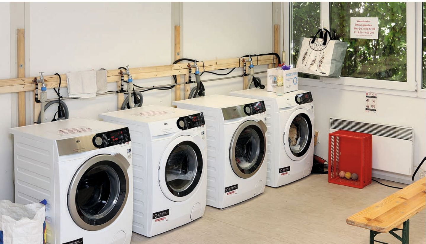
Der Waschsalon des Beratungszentrums vor der Erweiterung aufgrund der hohen Nachfrage. Bild: © Thorsten Trütgen
